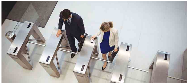
Системы контроля и управления доступом на объект
