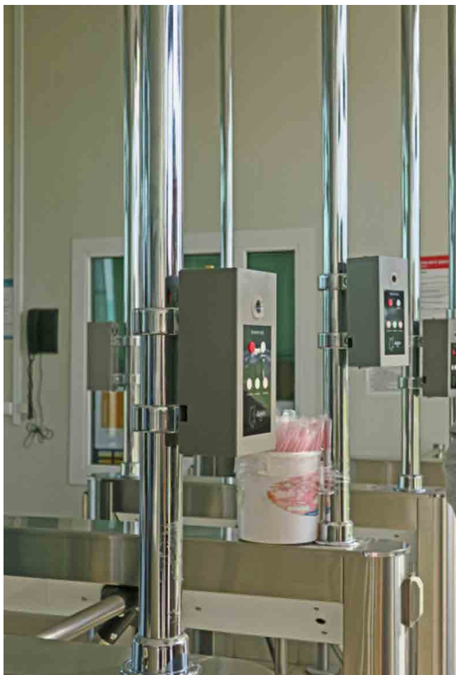
Проходная с системой СКУД и проверкой алкотестером
