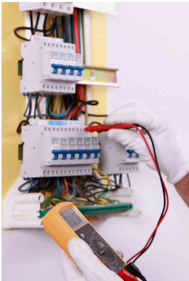
Монтаж систем безопасности «под ключ» – работа КОДОС ИНЖИНИРИНГ
